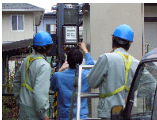
電力会社による送電前の メーター確認作業
