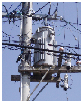
低圧契約の供給設備 柱上トランス(電力会社の設備)
